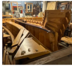
6.28 Demontierte Holztreppen
