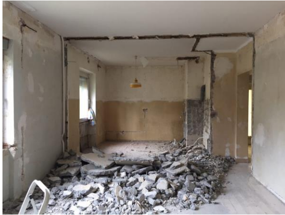
Abb. Anhang 21: Risiko bei Abbruch- und Rückbauarbeiten, bspw. durch Stolpern über Abbruchmaterial oder Abstürzen durch Bodenöffnungen (links: Piede 2017; rechts: Kess 2017)
